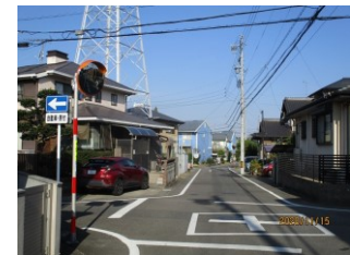
江端町六丁目地内に新設されたカーブミラー(写真③)
