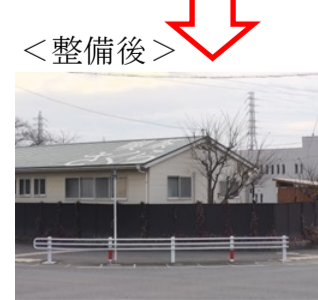
拡張されたガードパイプ(柘山八丁目交差点)
