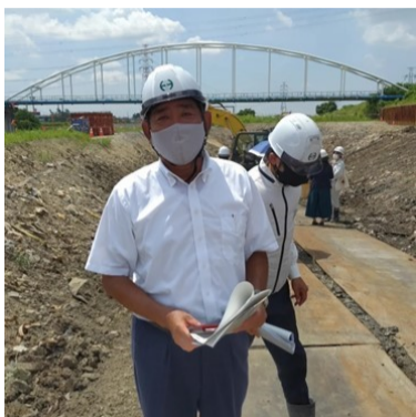
石ヶ瀬川と境川の合流地点での工事現場を視察
